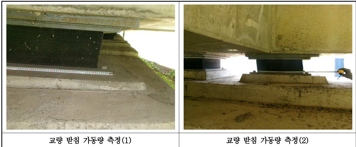
【사진 6.3.15】 교량받침 이동량 측정
