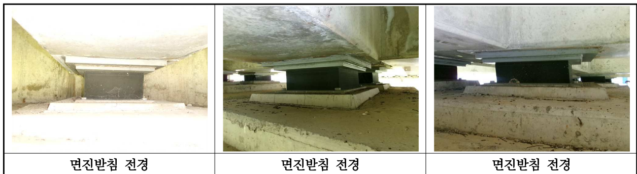
【사진 6.3.12】 교량받침 전경
