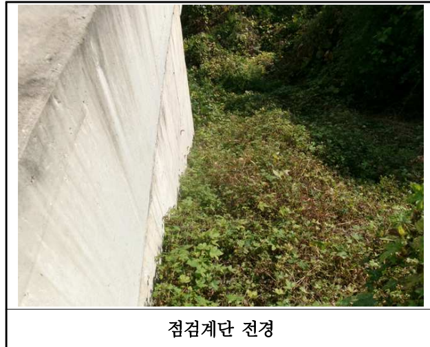
【사진 6.3.25】 교량 점검시설 전경
